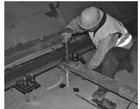
2. ábra A portálszerkezet beszerelése
