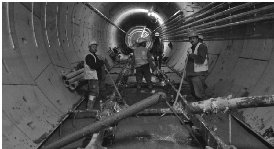
4. ábra Betonozáskor a vágányszerkezetet fóliával védjük
