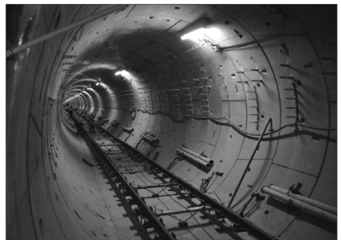
3. ábra A beállított vágányok pályabetonozás előtt
