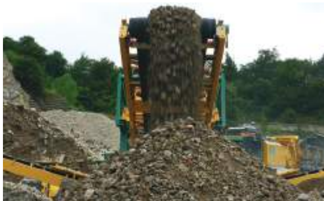
Építési és bontási hulladékok osztályozása újrahasznosítás céljából (fotó: RCH RECYCLING CENTER HIMBERG)
