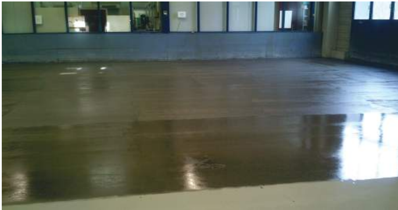
2. kép: Felújított ipari padló (fotó: Betonmix Kft.)
