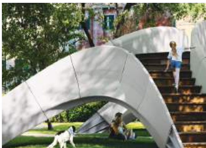
Striatus - 3D-nyomtatott boltozott híd (fotó: CeMBeton)
