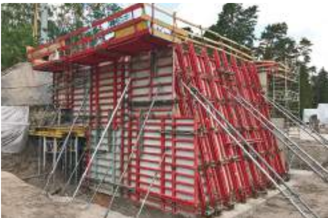
A francia A9 autópálya feletti híd
