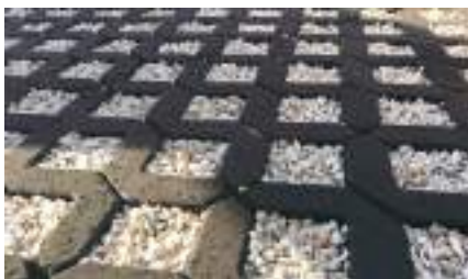
1-3. képek: Vízáteresztést biztosító beton burkolóelemek típusai
