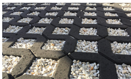
1-3. képek: Vízáteresztést biztosító beton burkolóelemek típusai
