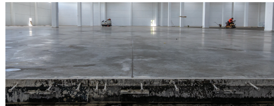
Szálak felhasználásával létrehozott betonpadló, a munka befejezésekor
