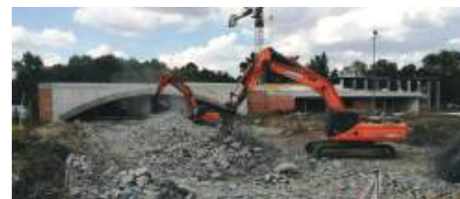
Vasbeton medence bontása
