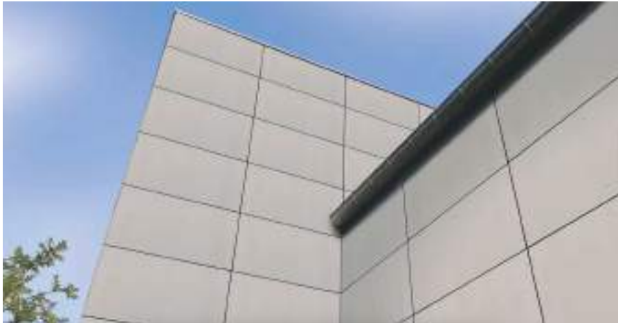
Szálcement burkolólemez 32 MPa hajlító-húzószilárdsággal
