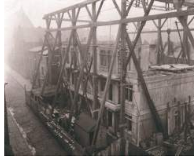
1. kép: Az Eldon Street Labourers' Concrete Dwellings építése 1904-ben. A felvételen jól látszik az épület építéséhez használt egyedi darurendszer, amelynek segítségével az egyes előregyártott paneleket a helyükre emelték.
