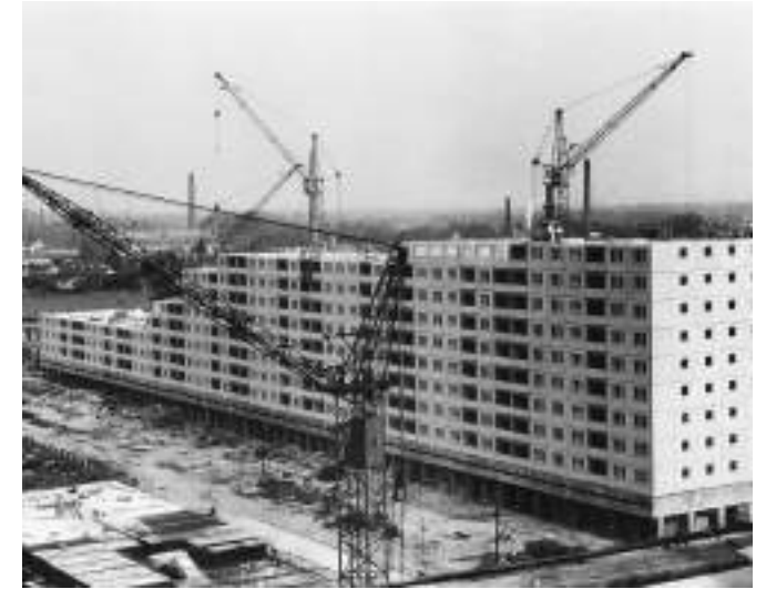
2. kép: Lakótelepi építkezés Óbudán 1970-ben. (A képen a mai Kerék utca lakóházainak építése látható.) Az Óbudai lakótelepen épült meg Magyarország legnagyobb, napjainkig is rekordtartó panelháza, a 886 lakásos ún. Faluház.
