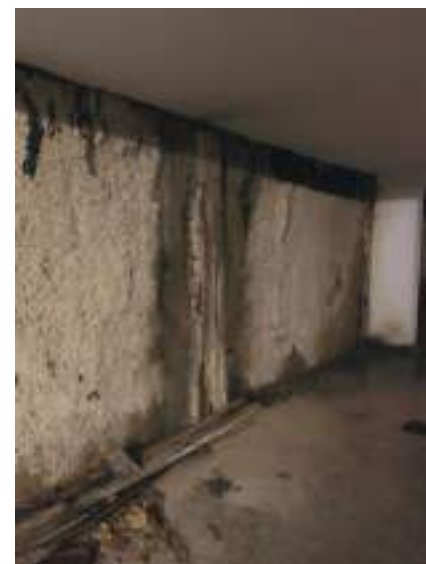
2.kép: Mélygarázs folytonos résfal egymáshoz illesztésénél hibás munkahézag-kialakítás.
