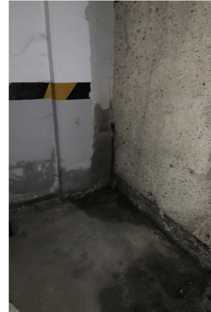
1.kép: Mélygarázsban a résfal és belső szerkezeti falazat között nem megfelelő a vízzáró kapcsolat.
