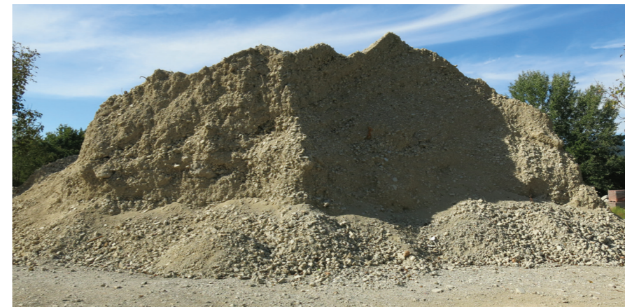
2. ábra: A pécsi „magasház” betontörmelékének feldolgozása és deponálása Pécsen (a szerző saját felvételei)
