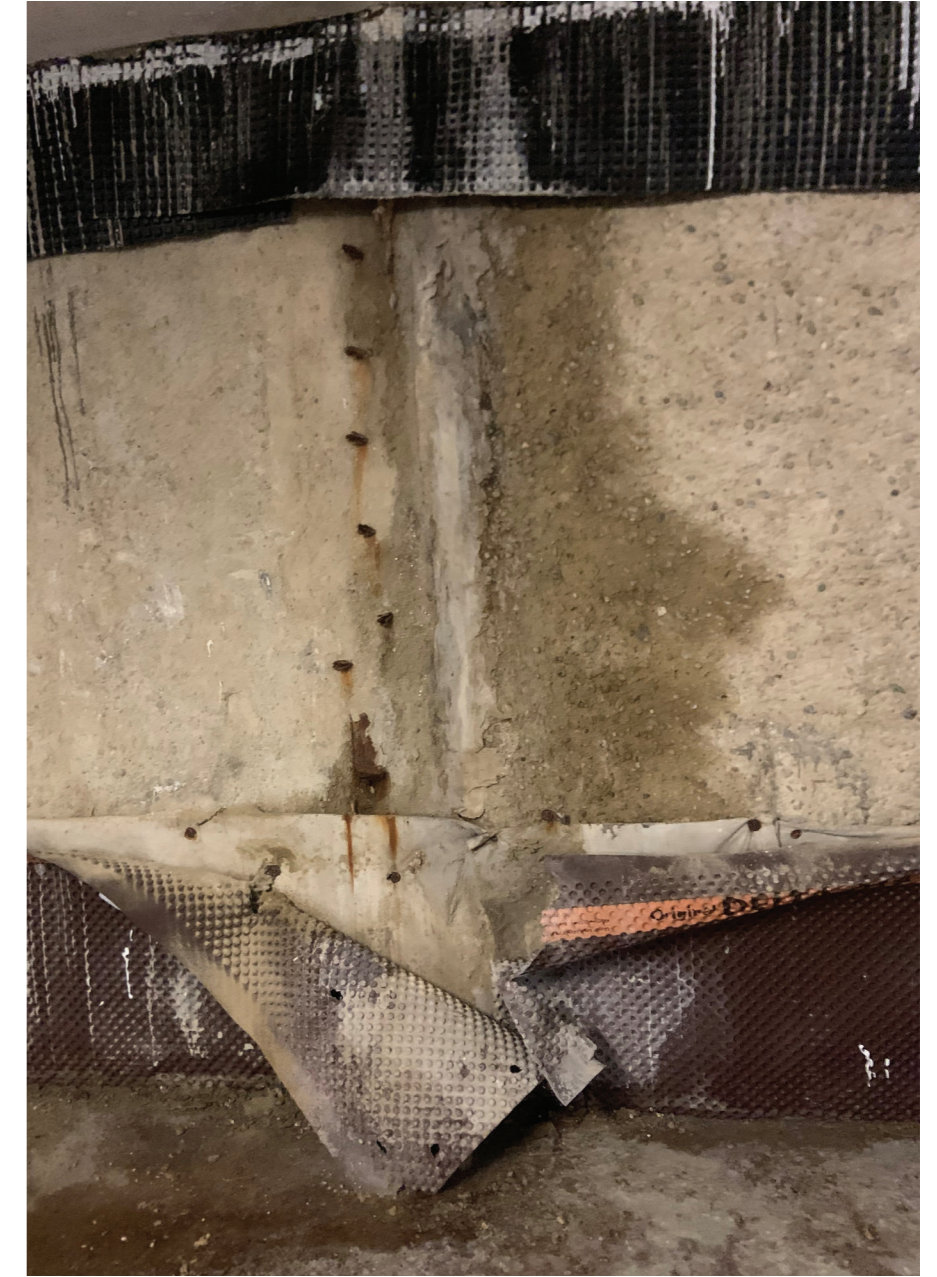
3.kép: Mélygarázsban a résfal munkahéznál nincs meg a megfelelő vízzáróság és a beton is túlzott mértékben átázott.
