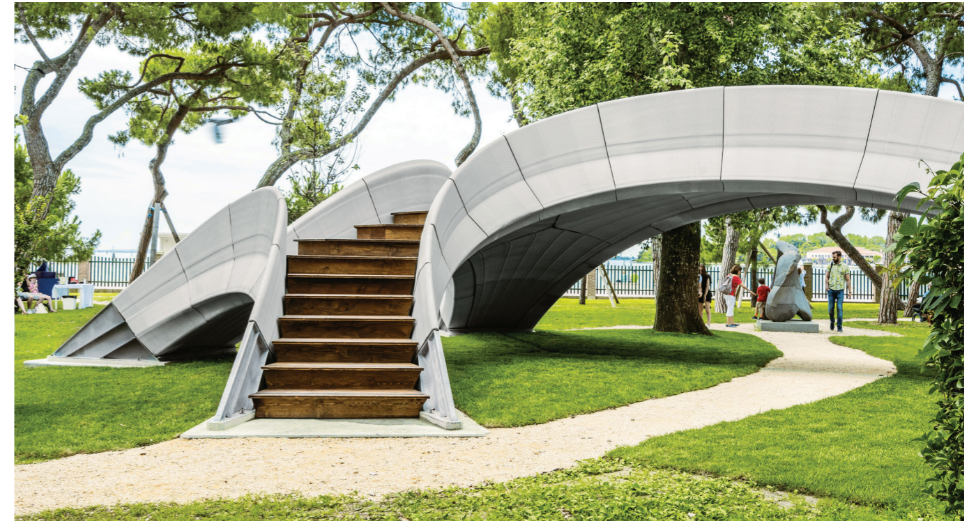
Striatu, a 3D-nyomtatott híd
