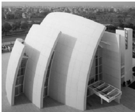
3. ábra Fotokatalitikus betonból előregyártott panelelemek
