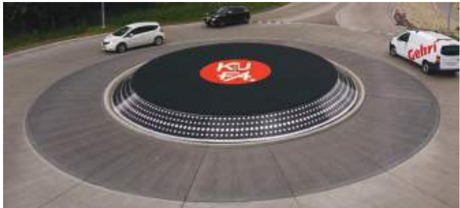
4. kép - A Bern kantonbeli Lyss településen található betonburkolatú „lemezjátszó” körforgalom (tervezte és kivitelezte, fotó: Gehri AG)
