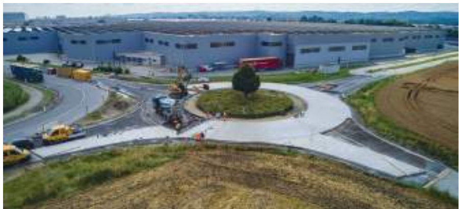
5.kép - A BMW dingolfingi üzeméhez vezető út betonkörforgalmának építése (fotó: ©HeidelbergCement AG/ Michael Voit)
