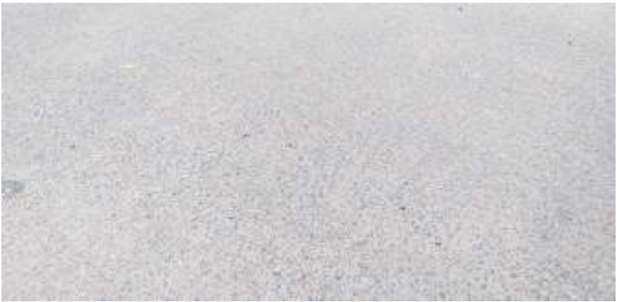
1. kép - A burkolatról készített közeli felvételen jól látszik a hálós repedés és a zúzalékszemszék (fotó: Dr. Bencze Zsolt)
