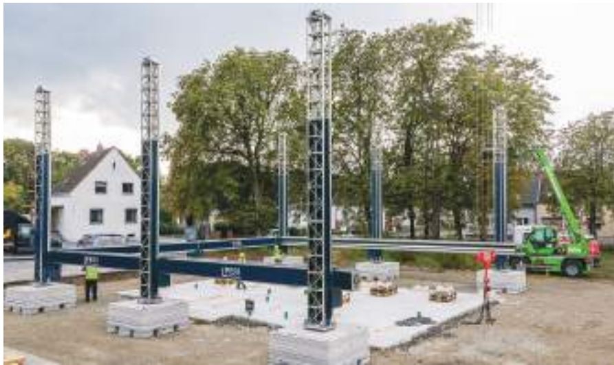
1. kép - A dániai COBOD cég által gyártott BOD2 nyomtató az építési helyszínen felállítva (Fotó - PERI)
