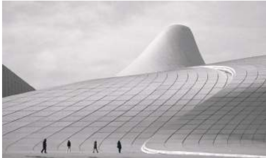
Városi beton infrastruktúra amatőr győztese és az összesített győztes
