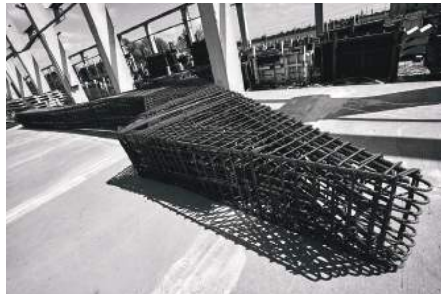
2. kép Pisztolytartó vasalása – 5 tonna betonacél a 35 tonnás tartóban
