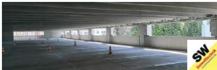
Belső pillérek nélküli parkoló-rámpa kialakítás
