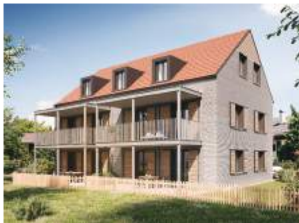
Ez nem egy kutatási vagy demonstrációs projekt, a lakásokat az építkezés után a megszokott módon bérbe fogják adni. Kép: PERI GmbH
