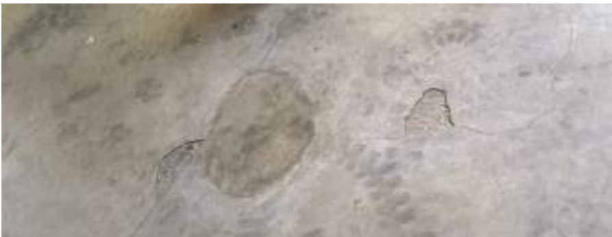
1. kép: Kéreg kitöredezése
