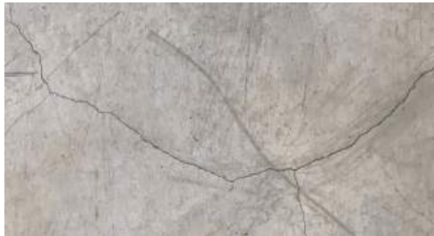
2. kép: Kéregfelválás, kéregrepedés
