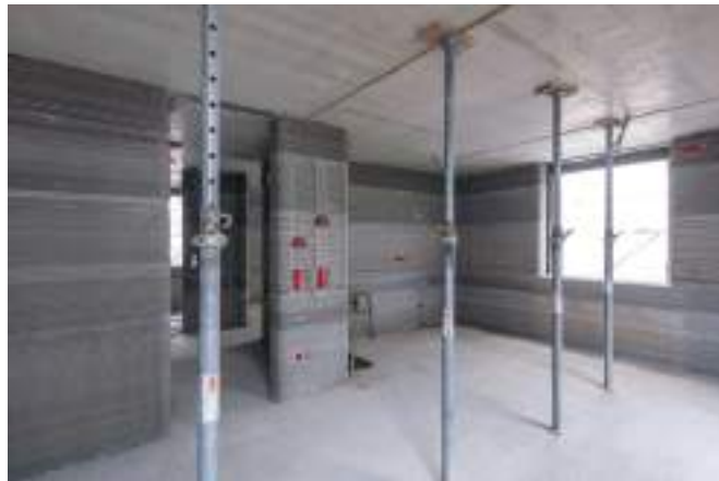
A HeidelbergCement „i.tech 3D” anyagának megbízható szilárdulása rendkívül pontos formakövetést tesz lehetővé. Kép: HeidelbergCement AG / Michael Voit
