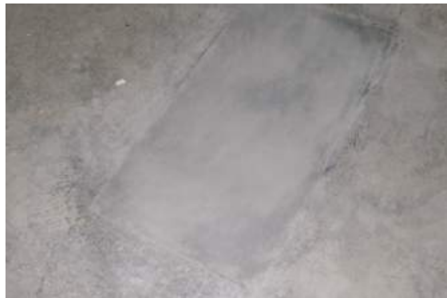
3. kép: Kéregfelválás javítása
