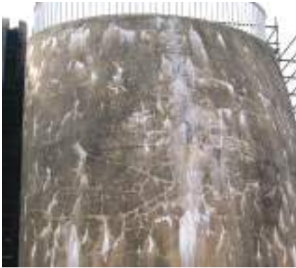
2. kép - Jellegzetes hálós repedésképp (forrás: Werner et al. 2015)
