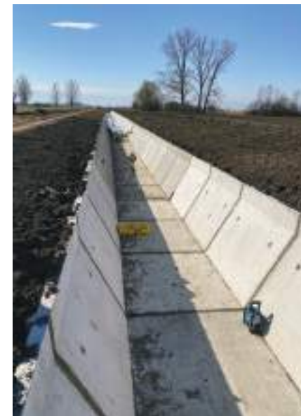
Derecskei-főcsatorna mederburkolási munkái a legkisebb méretű, 140 cm fenékszélességű mederelemmel
