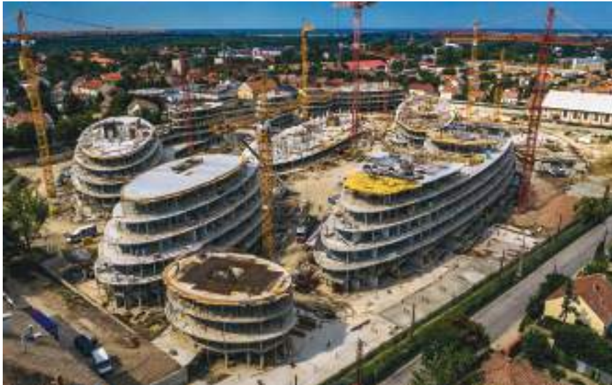
1. kép: Cédrus Liget Lakópark kivitelezése, Szeged
