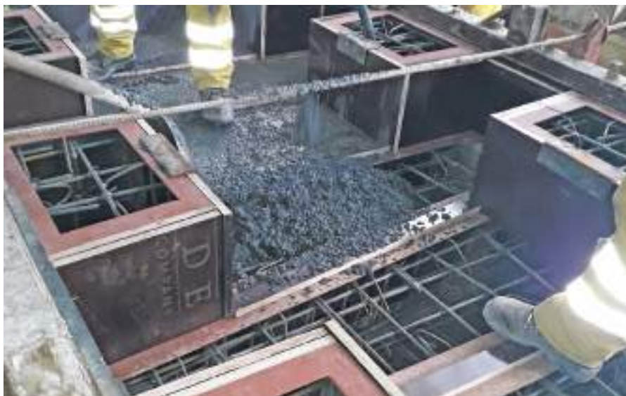
2. kép Az AW 183-as jelű elem öntése
