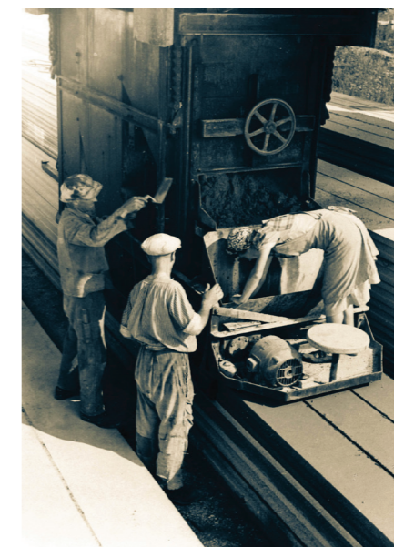
Beton tetőgerenda gyártása a leimeni betongyárban 1940 körül
