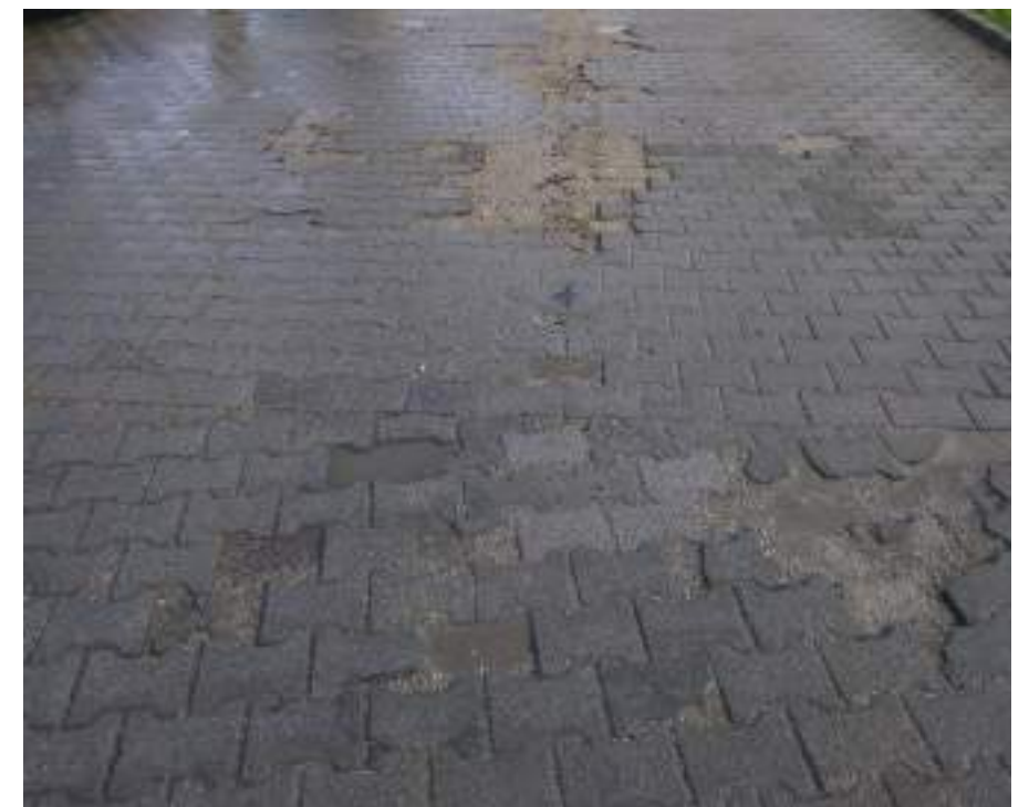
3. kép: Fagy hatására teljesen tönkrement térkövek.
