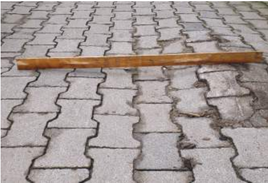
1. kép: A megsüllyedt alépitménnyel együtt süllyed a térkőburkolat is.
