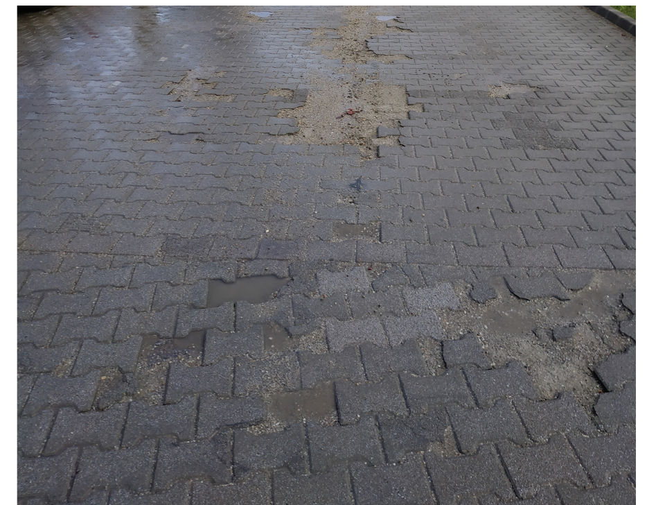
3. kép: Fagy hatására teljesen tönkrement térkövek.
