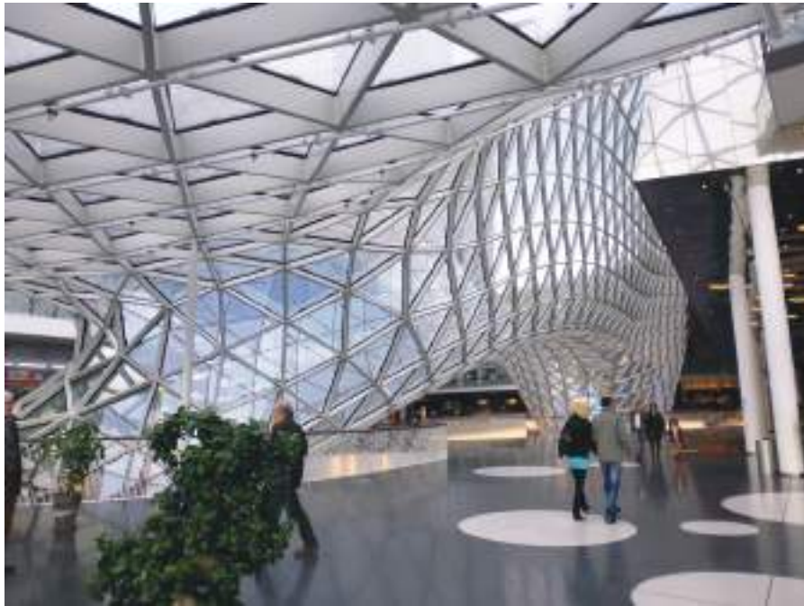
2. kép A MyZeil bevásárlóközpont héjszerkezetének belső képe
