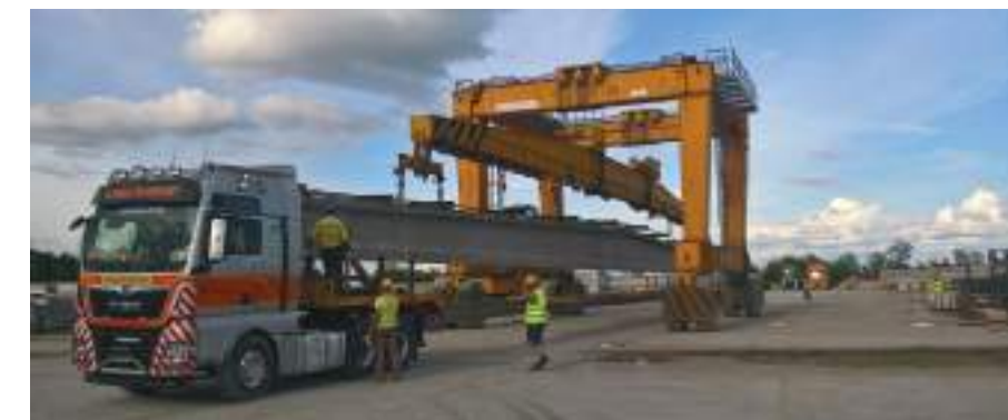
A közúti szállításra kész tetőgerendák
