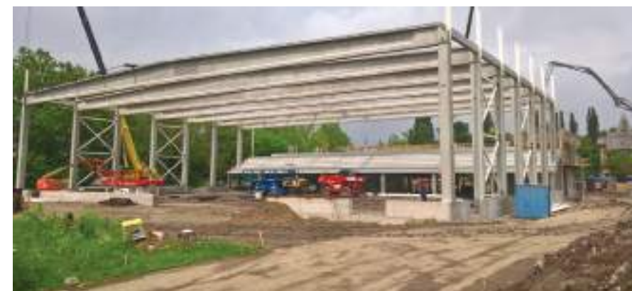
A tetőgerendák elhelyezése, szerelése
