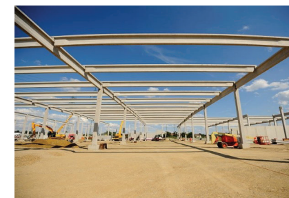
A bécsi METRO Simmering áruház tenderkiírás és a javaslat rajzon, majd a megépített szerkezet
