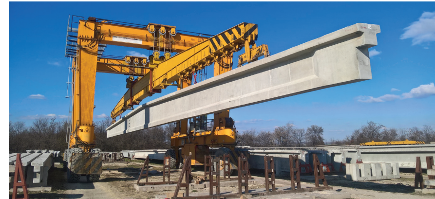
A tetőgerendák rakodása és deponálása a gyártóterületen
