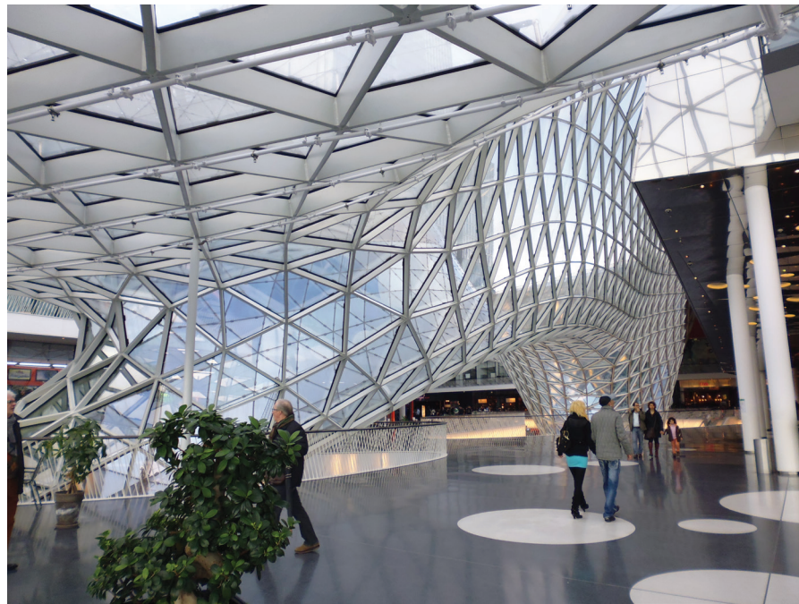
2. kép A MyZeil bevásárlóközpont héjszerkezetének belső képe
