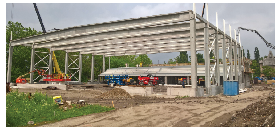
A tetőgerendák elhelyezése, szerelése
