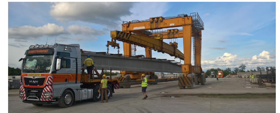
A közúti szállításra kész tetőgerendák
