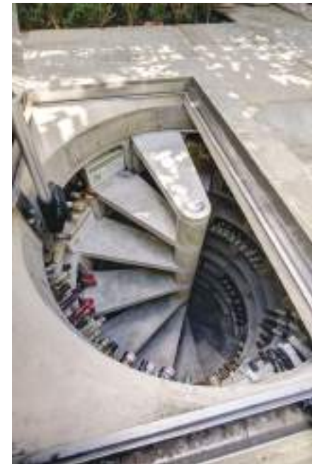
Kerti pihenő előtti betonterasz alá rejtett borospince.
