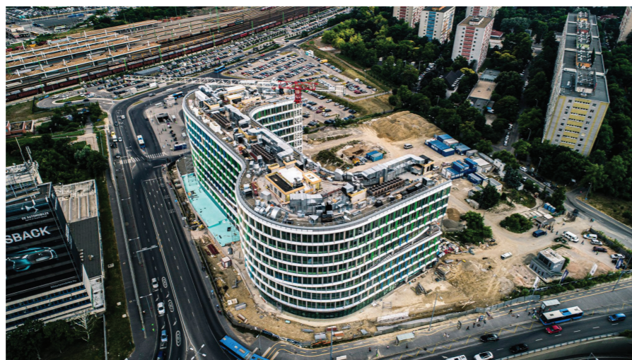
Budapest ONE irodaépület Standard fibrillált szálerősítésű aljzatbetonjai
