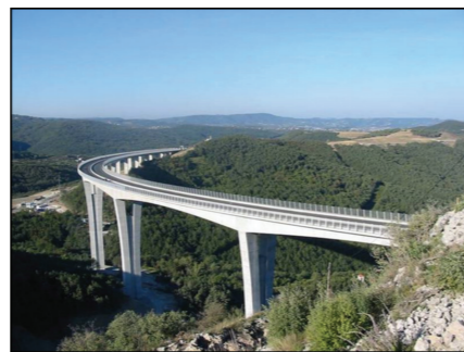
3. ábra: Črni Kal viadukt
