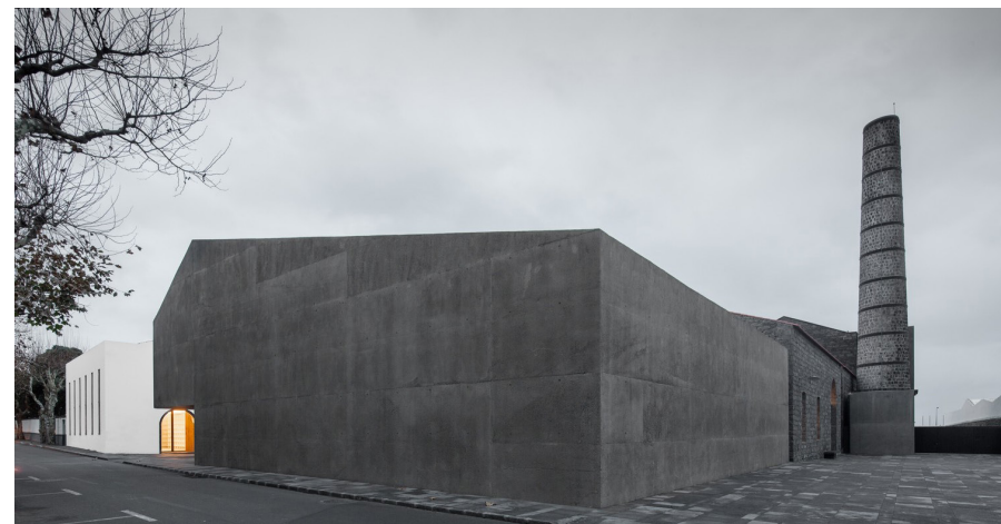
A bazaltbeton-felület csak távolabbi nézetben homogén. Közvetlen közelről szemlélve látható, hogy a sötétszürke felület képzésénél nem törekedtek az egyforma textúra kialakítására.
