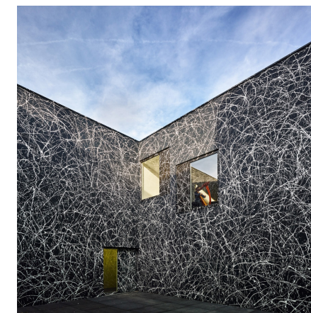
A sötétre festett alapbeton-felület betontextúrája érzékelhető, megjelenik a nagytáblás zsalukiosztás formavilága is. A festés szokatlanul elegáns és látványos külsőt ad a felületnek.
