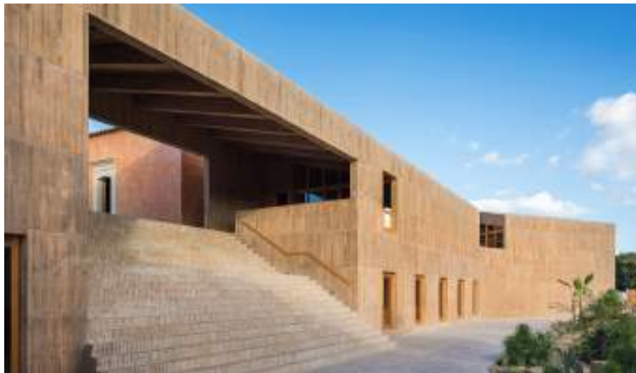
Pigmentált (barnászöröses) betonfalak és téglalépcsők jellemzik az épület homlokzatát
