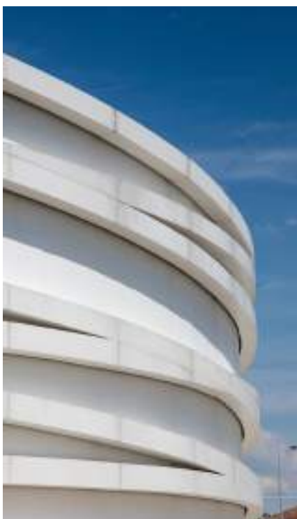
Drámaian kifejező előregyártott gyűrések a tömör fehér betonfelületen
