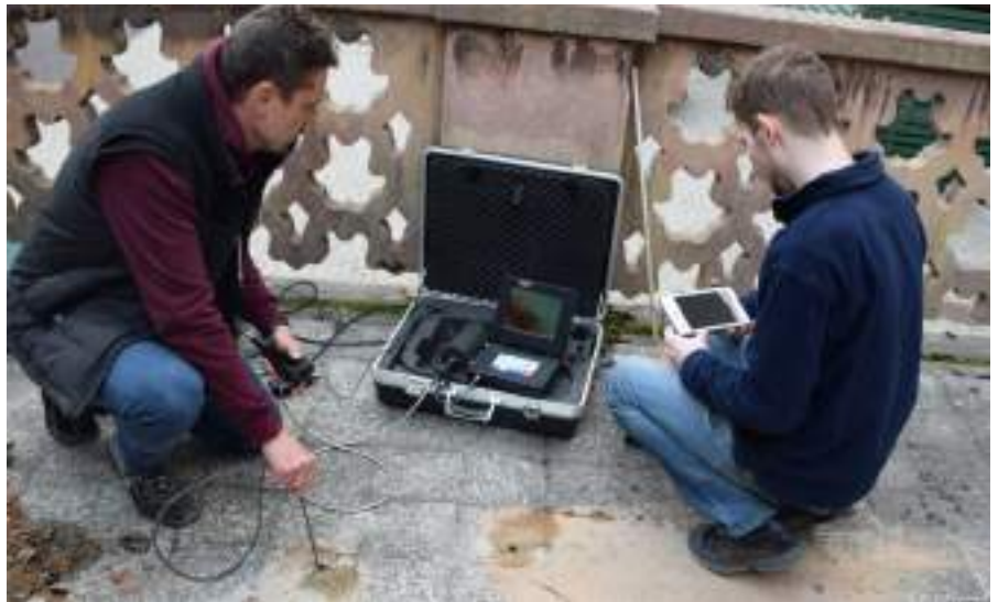
1929-ben épült vasbeton födém videoendoszkópos vizsgálata
