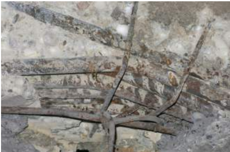
Bordás vasbeton zárófödém kialakítása (1910-es évek eleje)
