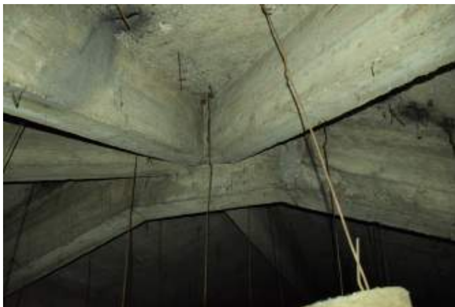
Kiévelt csomópont vasalásának kialakítása (1910-es évek eleje)
