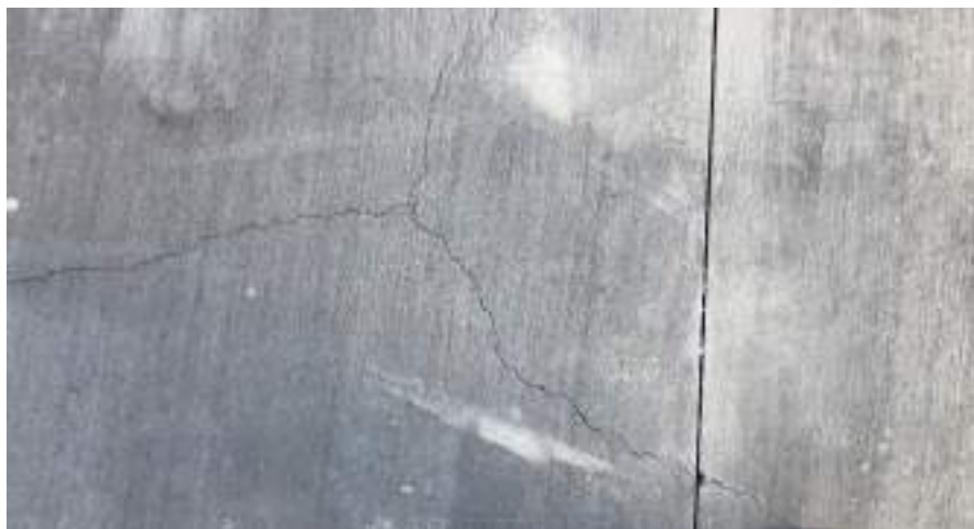
1. kép: A korai zsugorodási repedésekre jellemző a szabálytalan vonalvezetés és egy repedésvonalon belül is a változó repedésszélesség.
