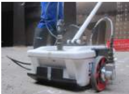
Radarvizsgálatok végrehajtása beton alaplemenzen
