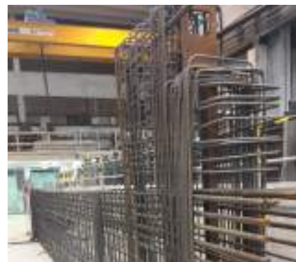
Egy pillér betonacél armatúrája, szerelt állapotban
