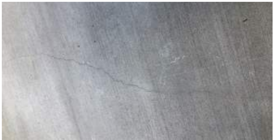
3. kép: Jellemző a korai zsugorodási repedésekre, hogy szabálytalan a vonalvezetésük. Vannak olyan repedések, amelyek tágassága csökken és a repedés nem fut ki a táblaszélig.
