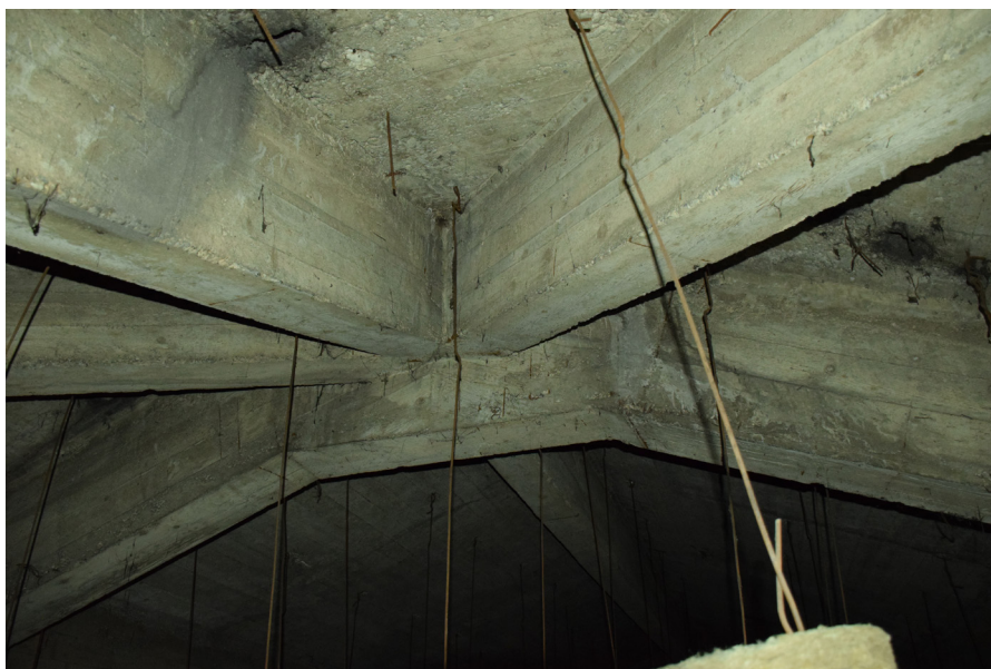
Kiévelt csomópont vasalásának kialakítása (1910-es évek eleje)
