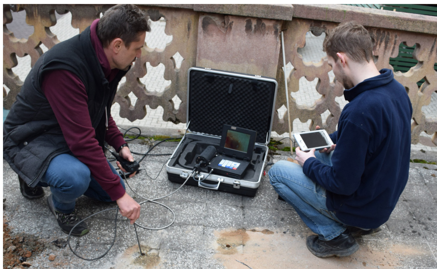
1929-ben épült vasbeton födém videoendoszkópos vizsgálata
