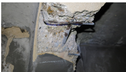
Egyetlen hosszanti betonacélt tartalmazó keresztmetszet (1910-es évek eleje)
