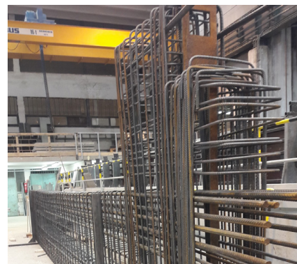
Egy pillér betonacél armatúrája, szerelt állapotban
