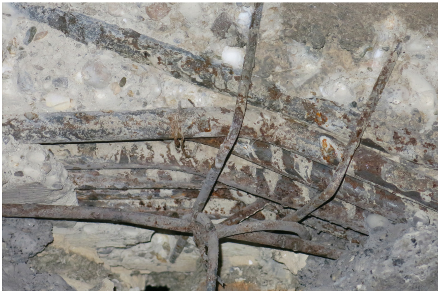
Bordás vasbeton zárófödém kialakítása (1910-es évek eleje)
