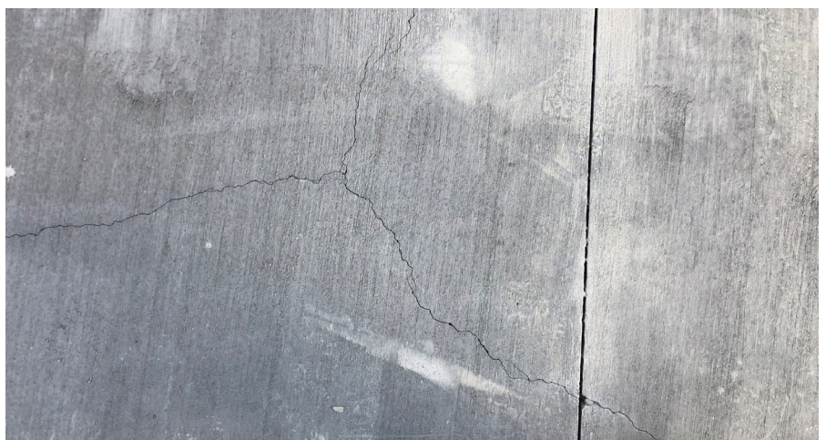
1. kép: A korai zsugorodási repedésekre jellemző a szabálytalan vonalvezetés és egy repedésvonalon belül is a változó repedésszélesség.
