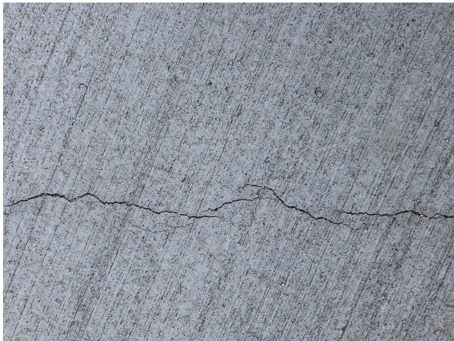
2. kép: Lehetnek 1,0 - 1,5 mm tágas repedések is.
