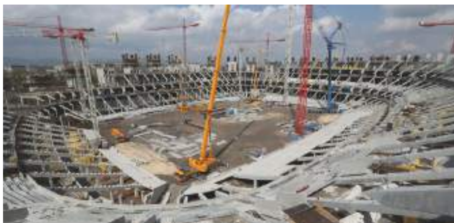
A Puskás Ferenc Stadion építése - Fotó: Wéber Zsolt
