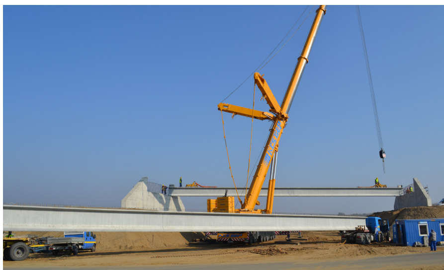
M6-os autópályára Baracsánál épült völgyhídja (H763-as híd)
