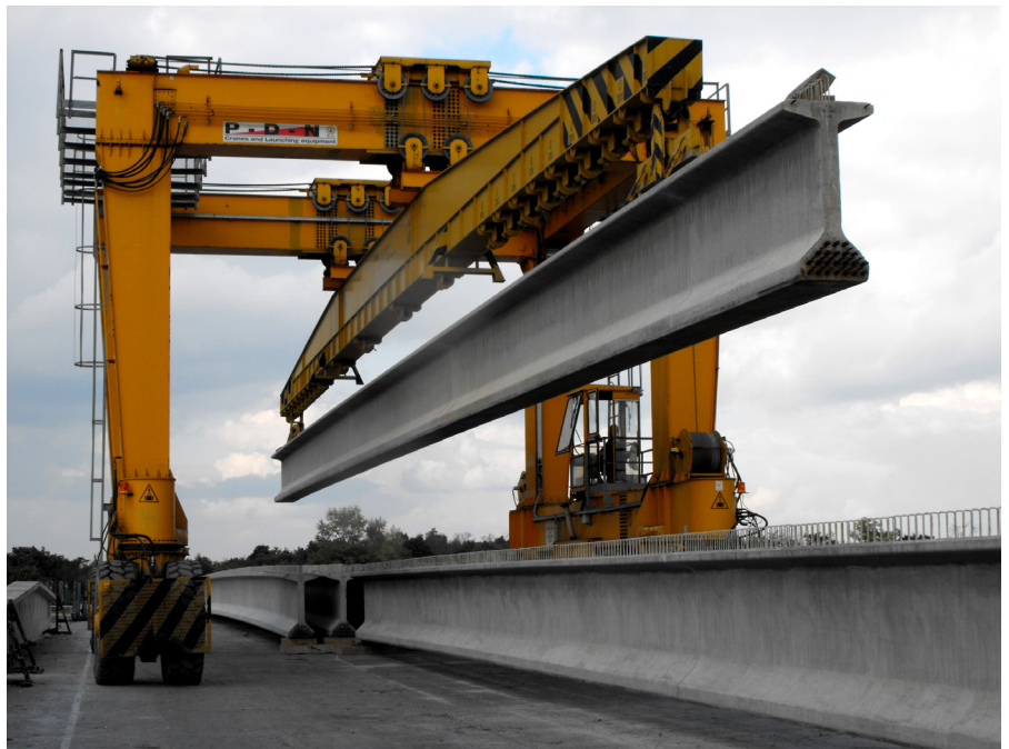
600 kN teherbírású önjáró, gumikerekes emelőgép, elemmel
