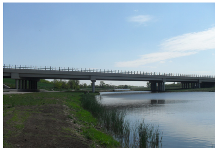
Völgyhíd építése az M6-os autópályán
