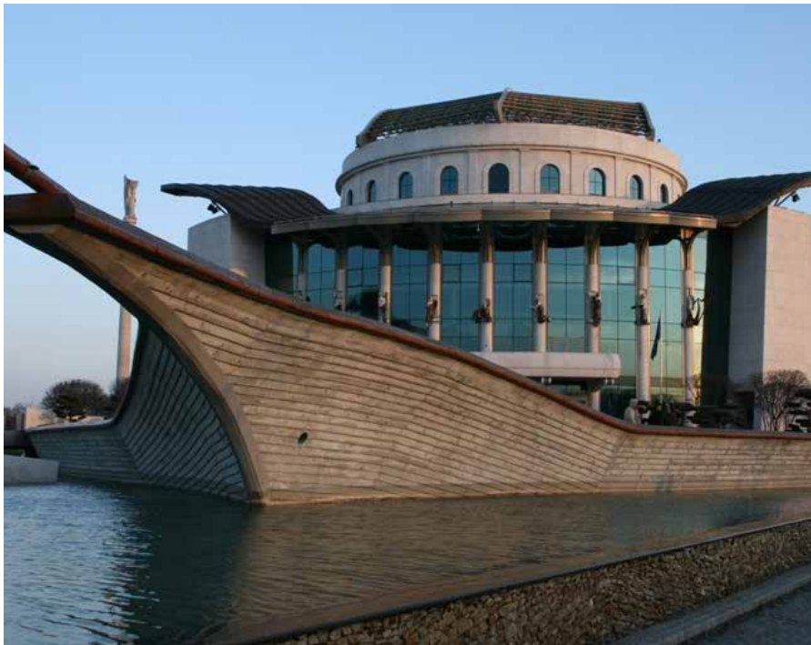
▲ Látványbeton felületek készítésének gyakorlati kérdései című cikk fotója (a Nemzeti Színház homlokzata). 2011. január
