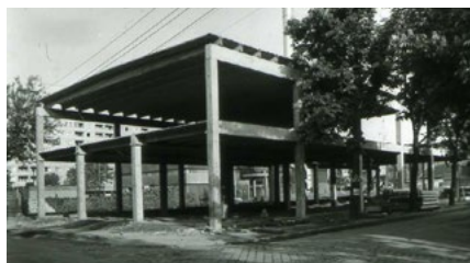
▲ Sütőüzem, Óbuda, 1971 Már a közbenső födém is TT panel
