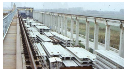
▲ TT födémek a hódmezővásárhelyi üzemben, 1978-ban
