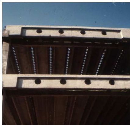
▲ A SKÁLA nagyáruház szerkezete 1975-ben még újdonság volt. 12 m * 12 m pillérállás
