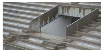
Befestigung FT-Brüstung an Tribünenbalken (Detail 1)
