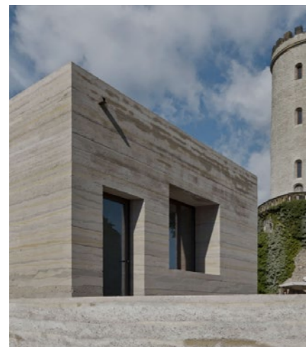
▼ 1. ábra: Csömöszölt beton homlokzati fal és támfal (1)
