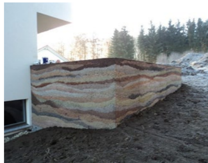
▲ 2. ábra: Színes, csömöszölt betonból készített támfal (2)
