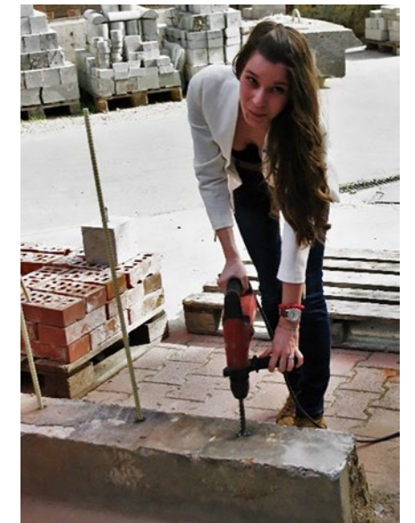
6. ábra: Az elbontott fal alapjába nem acél anyagú „vasalás” helyének befúrása, és a betétek beragasztása
