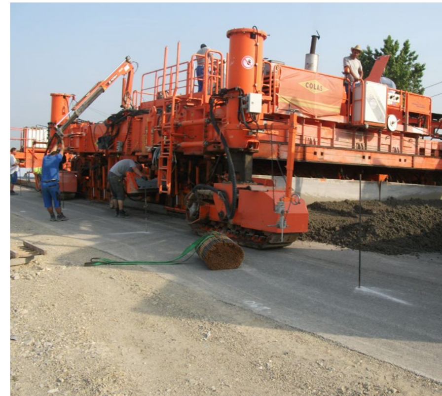
▲ Kétrétegű betonburkolat építése csúszózsálas finiserrel
