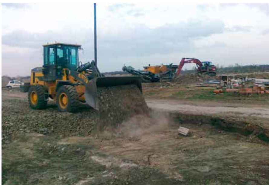
▲ Út alap készítése hasznosított építési-bontási hulladékból Forrás: Várkonyi Gábor
