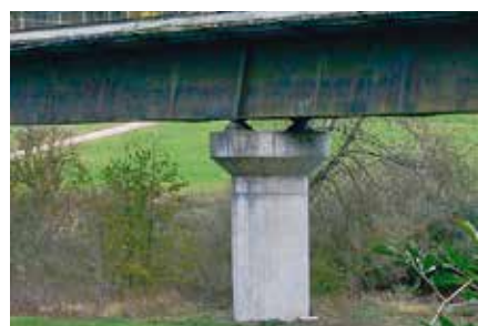
1. kép: Beuron, vasúti híd ▲ vasbeton cölöpön (Baden-Württemberg)
