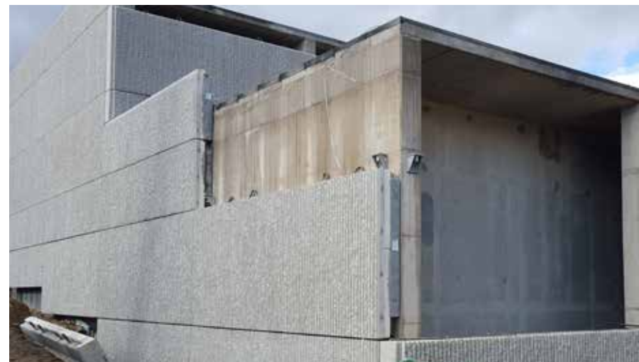
Az épület déli homlokzata építés közbeni állapotban ▼
