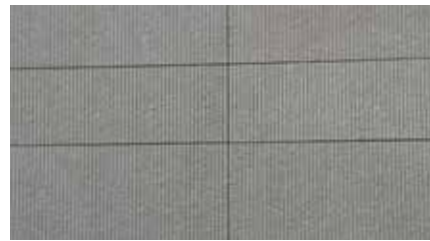
▲ Bordázott felület, az egymás alatti-feletti elemek bordái illeszkednek egymáshoz
