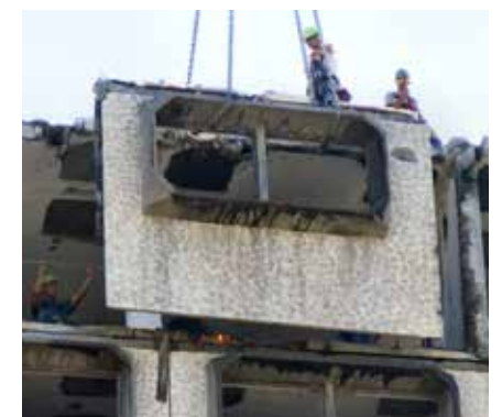
▼ A homlokzati falpanel kibontása a vázszerkezetből
