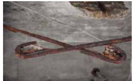
▲ 5.ábra: Hajdani átfedékes toldás
