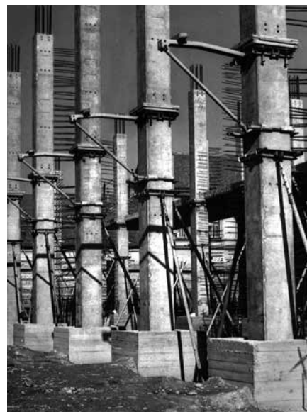
▲ Az IMS vázszerkezet szerelése (Pécs, 1975)
