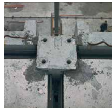
▲ PU paszta a pillér-födém csomópontban
