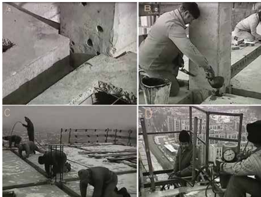
▲ Az IMS vázszerkezet szerelése (Pécs, 1975)
