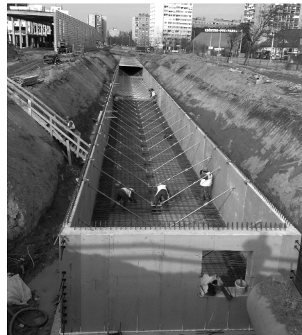
1. ábra Záportároló medence szerelés közben
