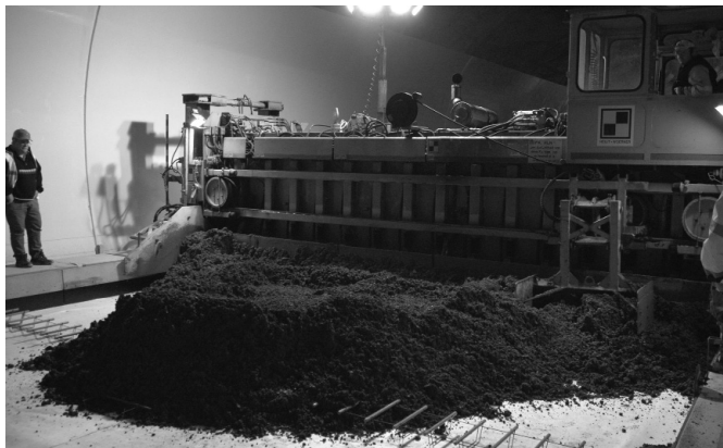
2. ábra A zsaluzatba ömlesztett beton
