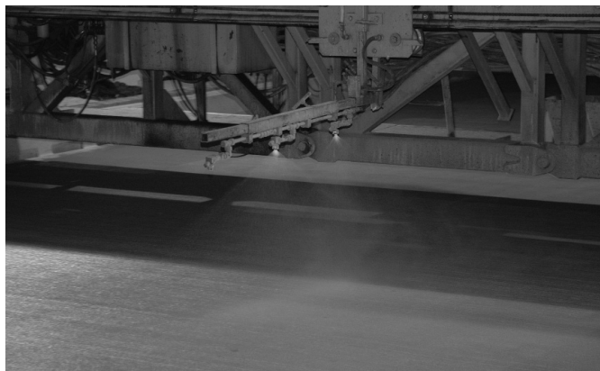
5. ábra Utókezelés párazáró szer permetezésével
