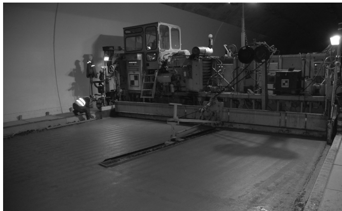
3. ábra A felület simítása géppel
