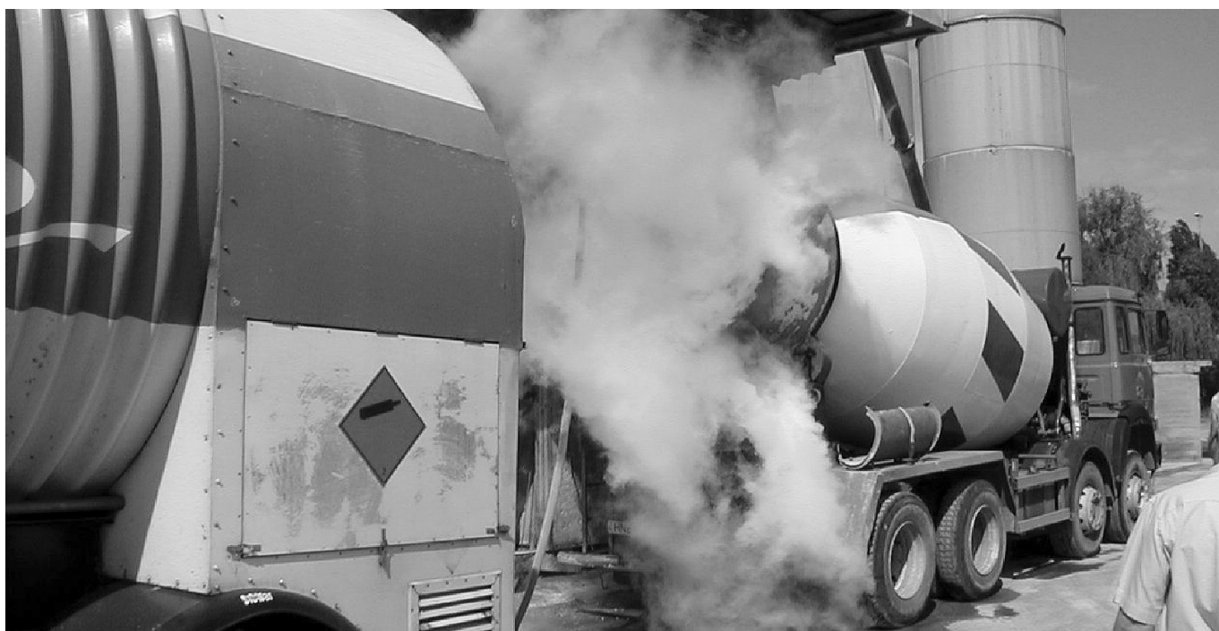
2. ábra Beton hűtése a mixer kocsiban
