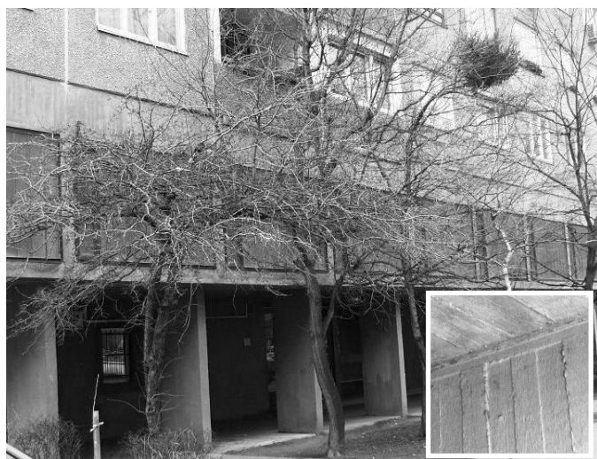
4. ábra Panelház fogadószintje monolit vasbetonból
