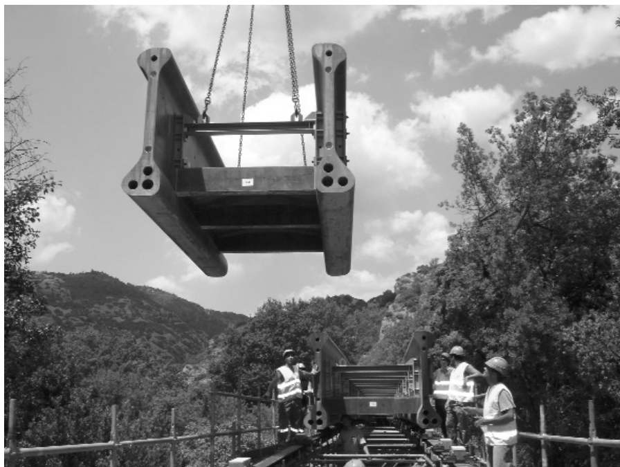
4. ábra Hídelemek beemelése daruval
