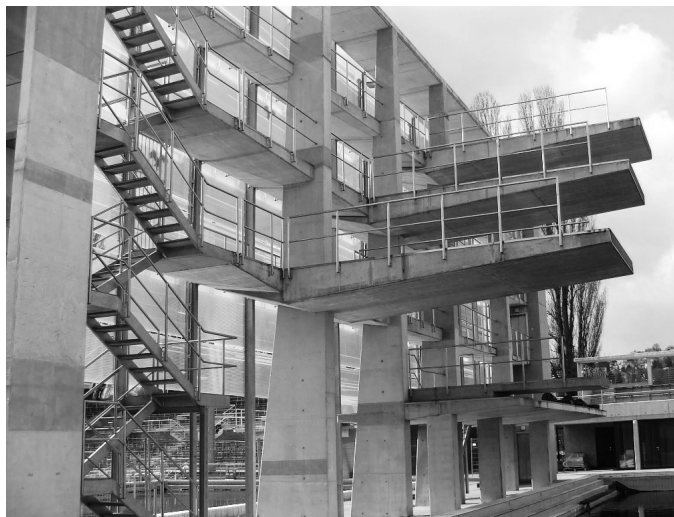
7. ábra Ugrótorony látszóbeton felülete, Sportuszoda
