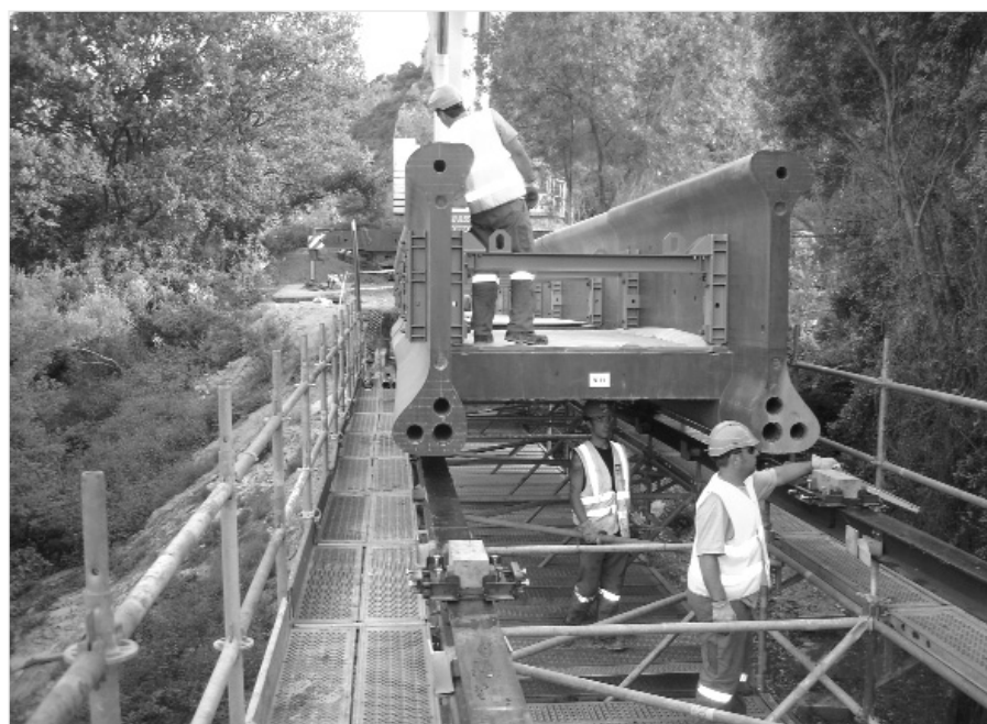
5. ábra A híd szerelés közben
