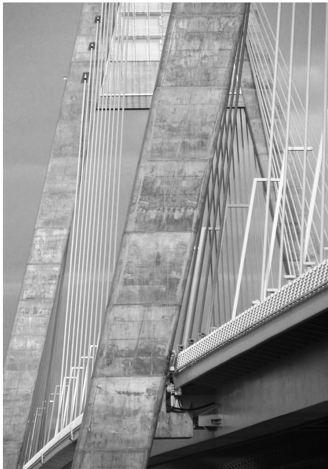
8. ábra Beton hídpillérek, Megyeri híd
