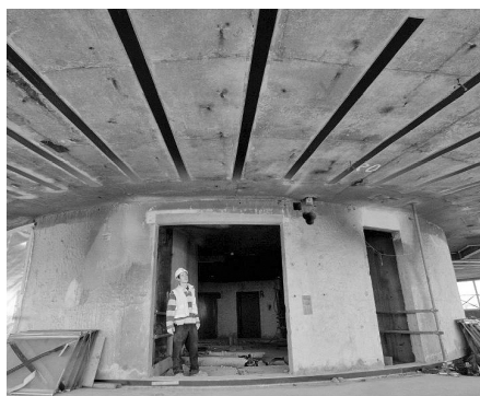
3. ábra A földem megerősítése CFK lamellákkal
