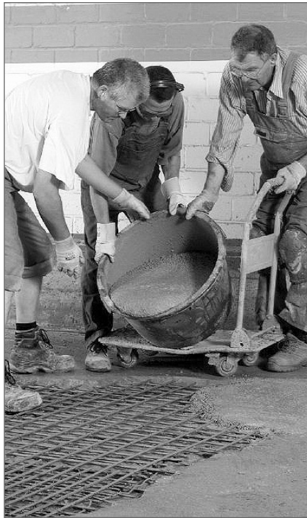
5. ábra Betonpadló újraöntése
