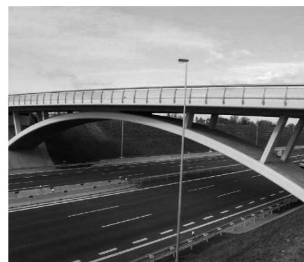
2. ábra Ívszerkezetű felüljáró
