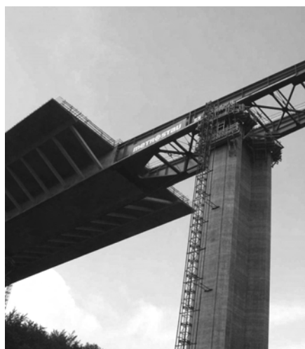
5. ábra Építés alatt a híd a Rybny patak fölött
