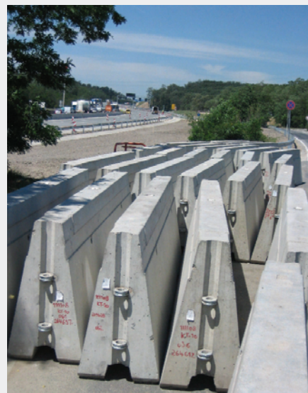
2. ábra Bevetésre készen sorakoznak az előregyártott vasbeton forgalomterelő elemek
