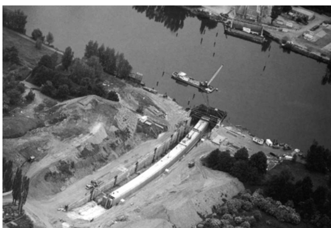
4. ábra Az alagútcső a száraz dombokban készült el, ezután eresztették az előkészített folyómederbe
