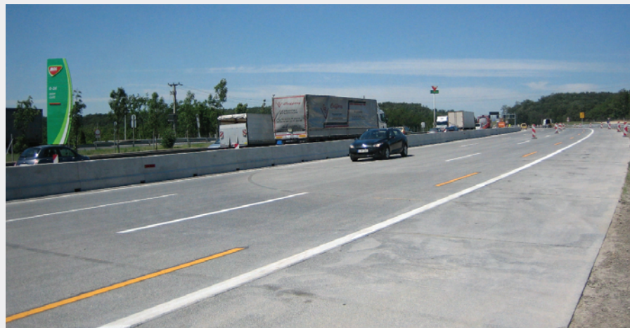
1. ábra Az elkészült betonburkolatú pálya az Annahegyi pihenőnél
