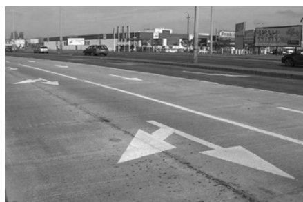
1. ábra Az elkészült betonburkolatú kísérleti szakasz
