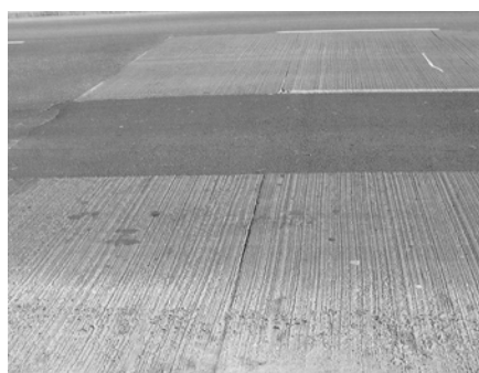
10. ábra Javítás aszfalttal
