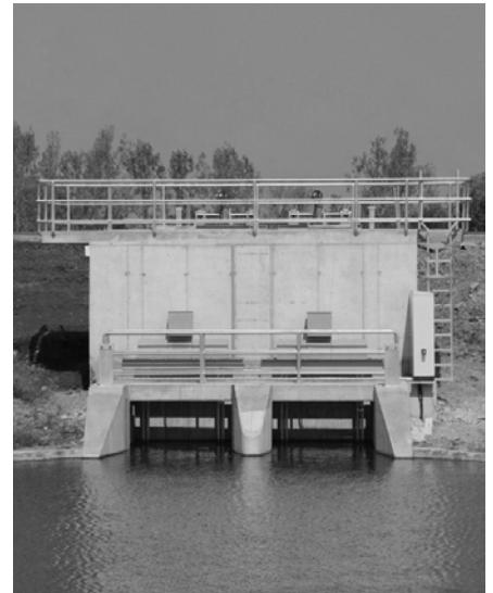
2. ábra Tározótöltést keresztező zsilipműtárgy
