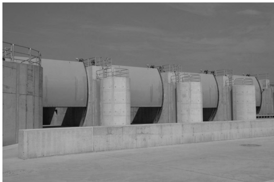
1. ábra A töltő-ürítő műtárgy a négy acél szegmenstáblával
