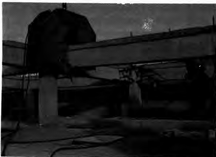
4. ábra Bontás roppantó készülékkel
