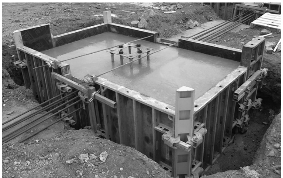
2. ábra Cölöpöket összefogó monolit vasbeton fejtömb, a kivitelezés során elhelyezett pillérindító szerelvényekkel
