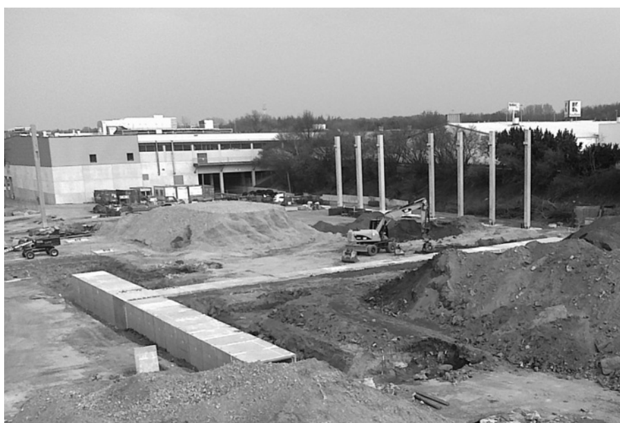
4. ábra Az épület kiürítésére szolgáló, padló alá tervezett menekülő folyosó is előregyártott vasbeton elemekből készült
