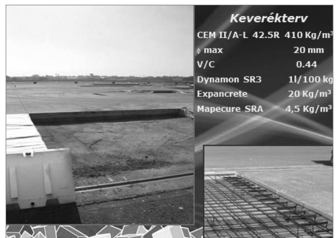
6. ábra Keverékterv repülőtéri kifutópálya betonjához, és kivitelezési pillanatképek
