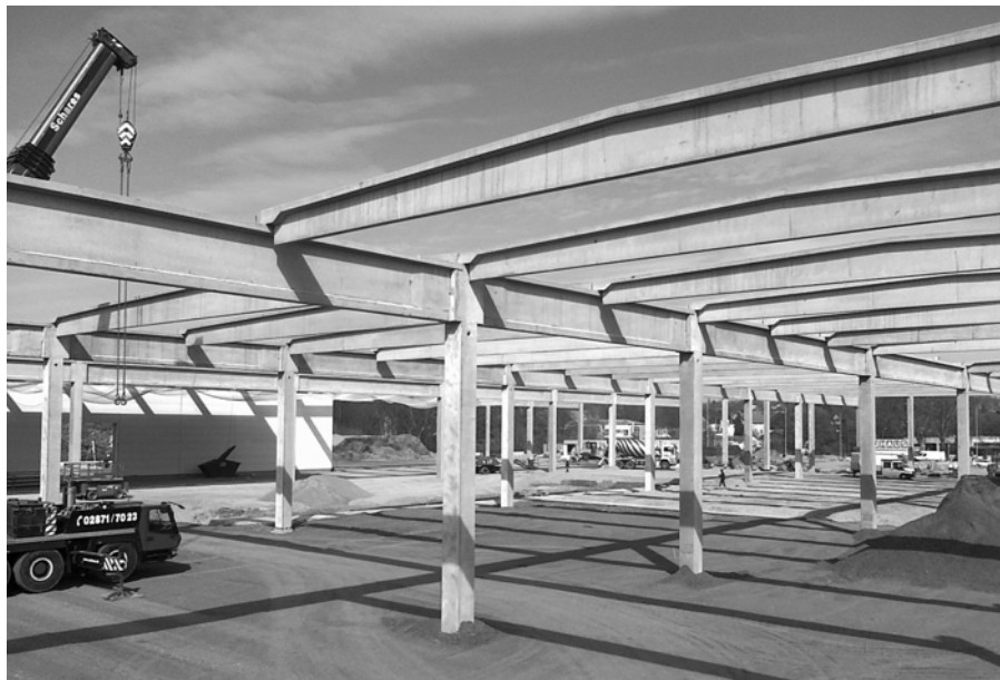
3. ábra A vázszerkezetet 6,0×6,0 m-es rasterhálóba illeszkedő pillérek, 18,00 és 24,00 m hosszú feszített vasbeton szelemenek alkotják
