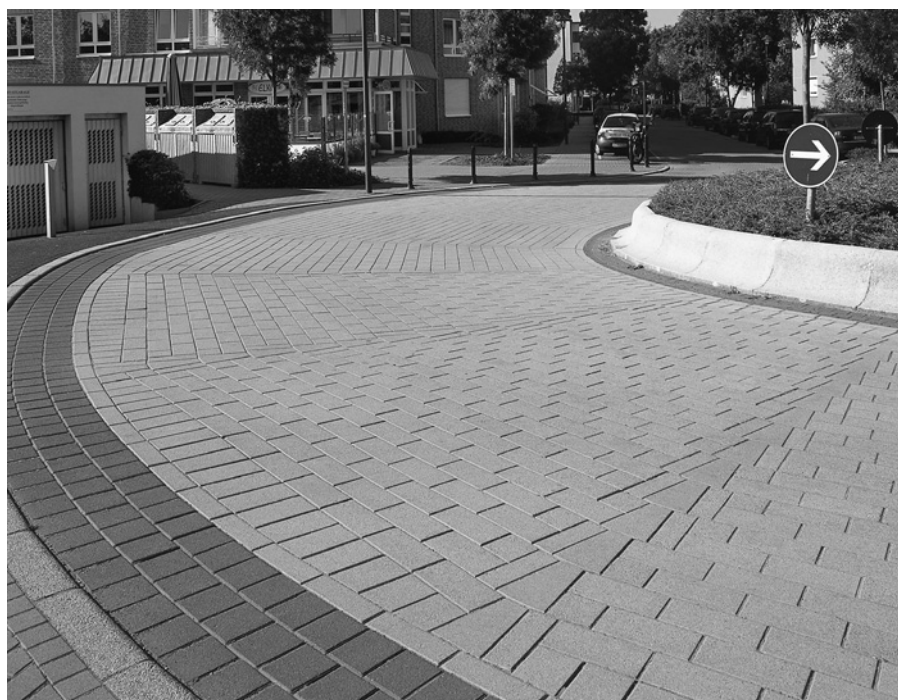
2. ábra Einstein kővel burkolt körforgalom
