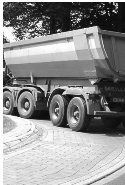
5. ábra Einstein burkolat a körforgalom belső gyűrűjében
