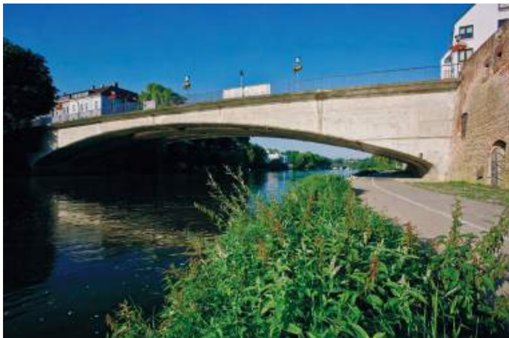
4. kép Ulm, a Herdbrücke felsőpályás vasbeton ívhíd
