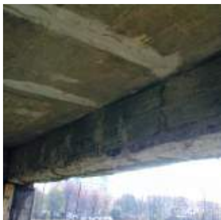
3. kép Durva javítás PCC4-el
