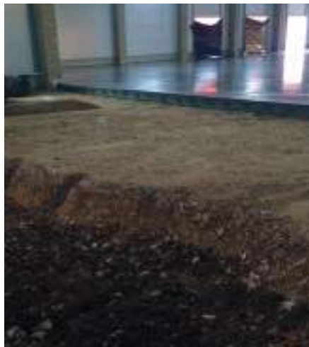
2. kép Az ágyazat cseréje, és a közben elkészült padló részlet
