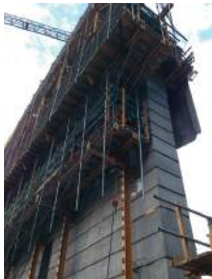
2. kép Homlokzati részlet, jól látható a 4x0,7 méteres felületosztás
