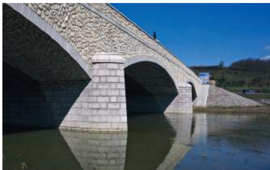
5. kép A Rárópuszta - Rárősi magyar-szlovák vasbeton határhíd az Ipolyon
