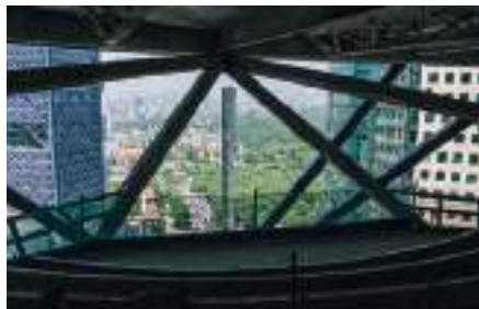
4. kép Az üvegfalas homlokzat merevítő rendszere. Kitekintés az építés alatt álló épületből
