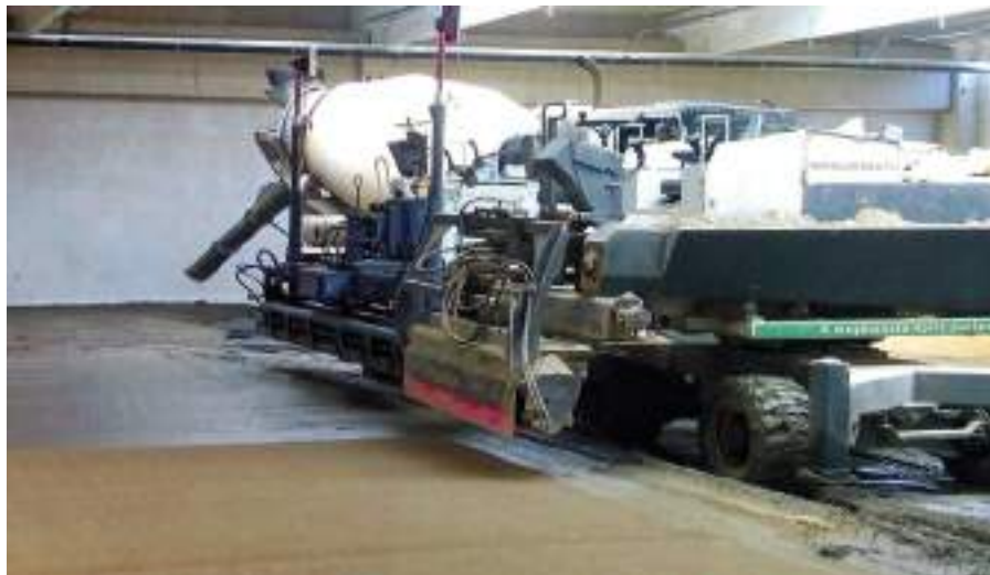
3. kép Laser Screed tömörítő pad
