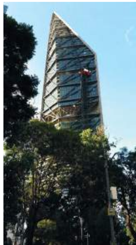
3. kép Az üvegfelületek előtt elhelyezett V merevítő sora. Nem csak esztétikai szerepet szánt nekik a tervező
