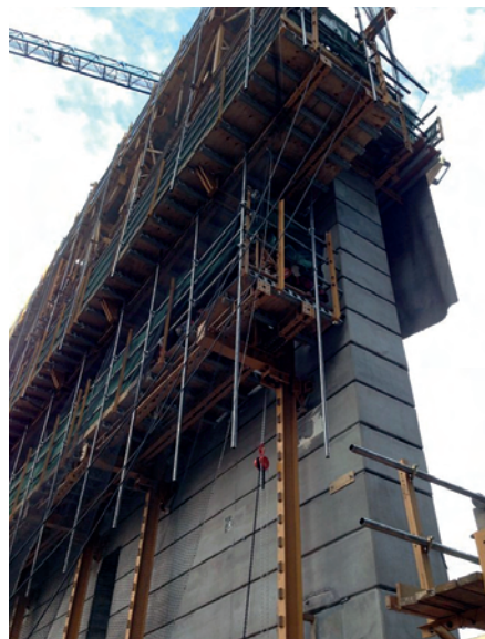
2. kép Homlokzati részlet, jól látható a 4x0,7 méteres felületosztás
