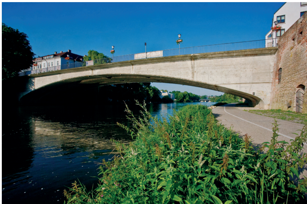
4. kép Ulm, a Herdbrücke felsőpályás vasbeton ívhíd
