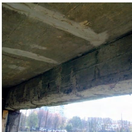
3. kép Durva javítás PCC4-el
