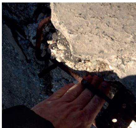
1. kép Beton korrózió
