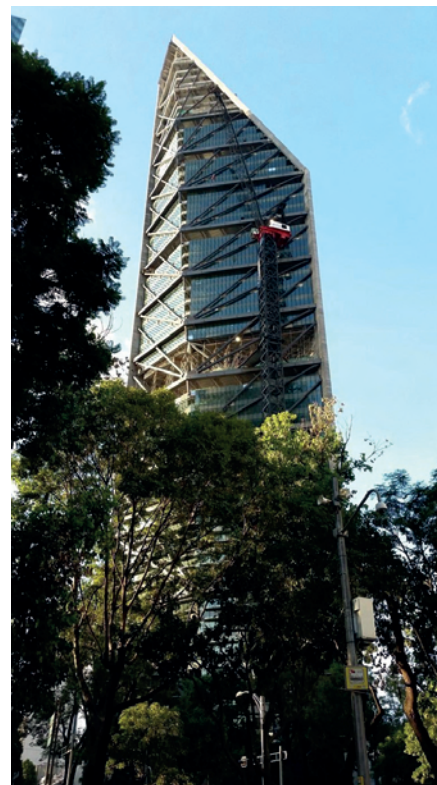
3. kép Az üvegfal felületek előtt elhelyezett V merevítők sora. Nem csak esztétikai szerepet szánt nekik a tervező
