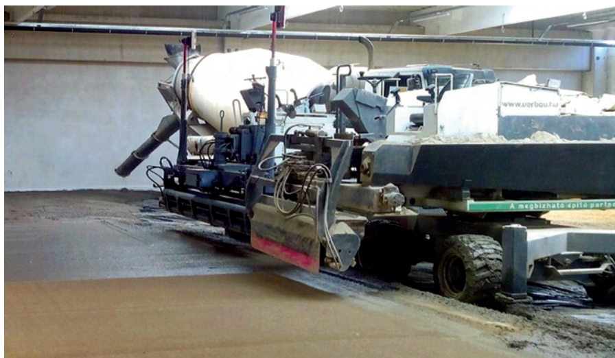
3. kép Laser Screed tömörítő pad
