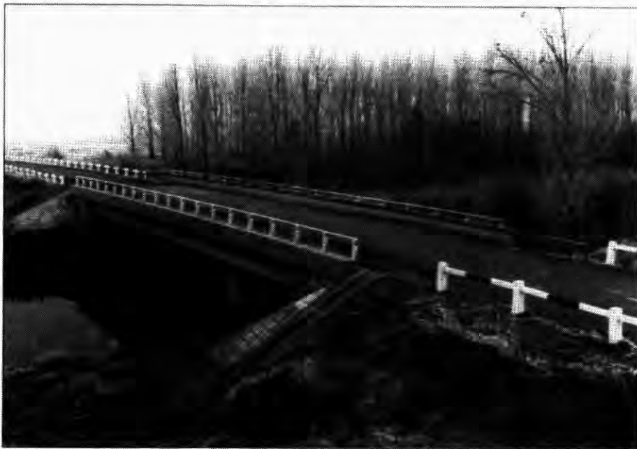
Híd a Hortobágy főcsatornán
