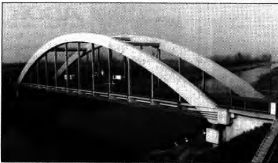
Keleti főcsatorna híd a Nyékládháza - Debrecen útvonalon
