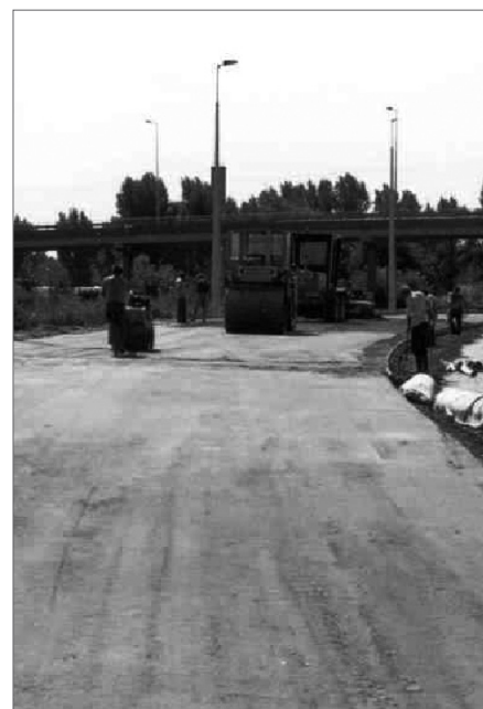
4. ábra Az 56-os számú főút Szekszárdi elkerülő szakaszán hengerelt beton burkolatalap
