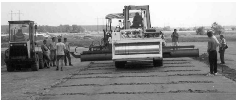
11. ábra Az aszfalt finiszerrel elterített és előtömörített betonréteg keresztirányú hézagológép kivágta
