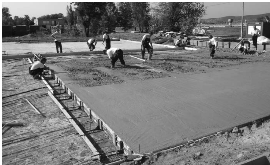
1. ábra Beton bedolgozása
