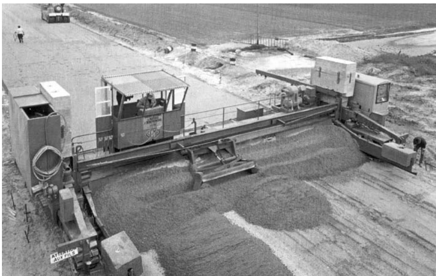
5. ábra Közetalmazok és hidraulikus kötőanyagú keverékek terítésére alkalmas terítógép
