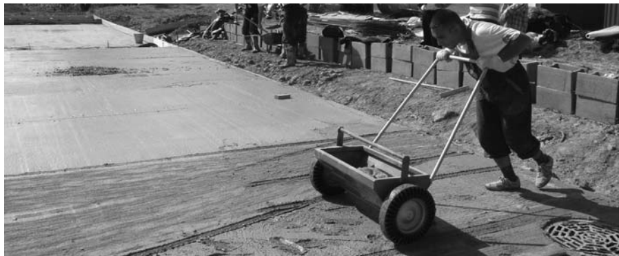
2. ábra Kéregerosztó anyag szórása a friss betonfelületre
