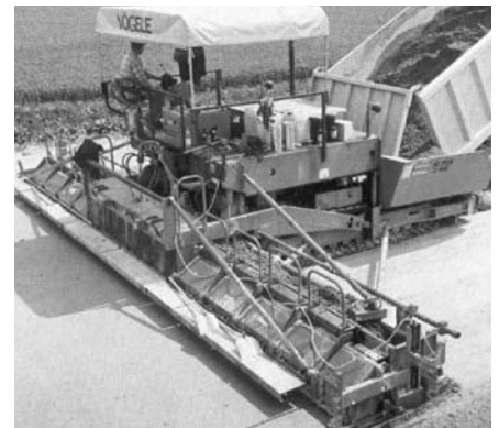
6. ábra Aszfalt finiser betonkeveréket terít
